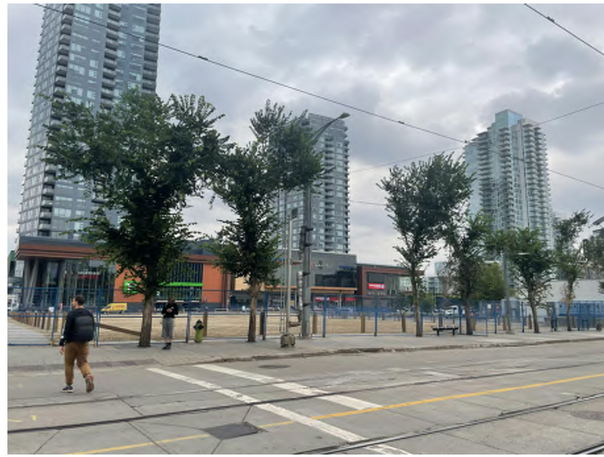
8 DP1.1 EXISTING SITE PHOTO 8 SCALE: N.T.S.
