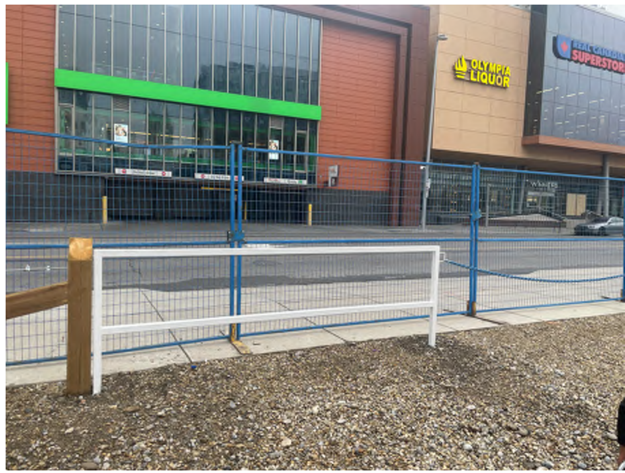
10 DP1.1 EXISTING SITE PHOTO 10 SCALE: N.T.S.
