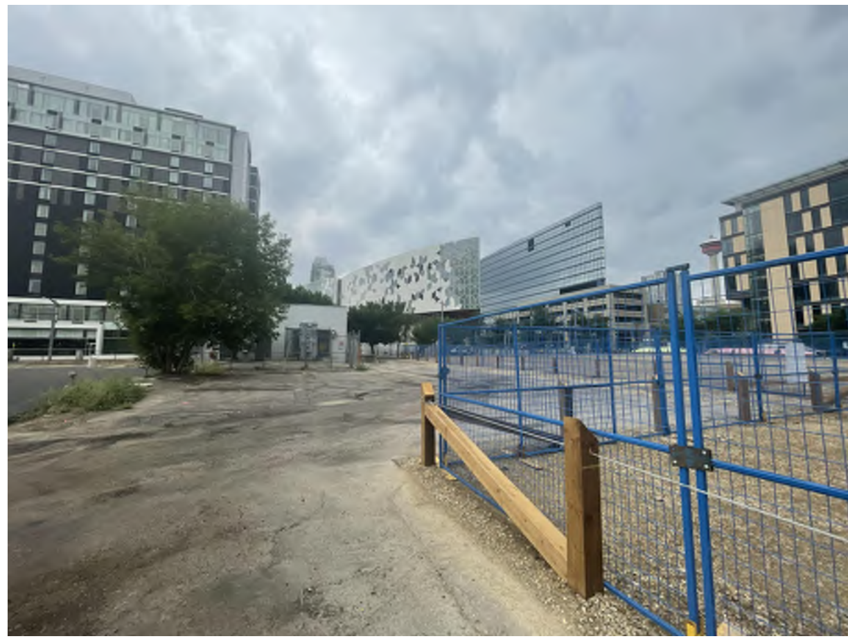
7 DP1.1 EXISTING SITE PHOTO 7 SCALE: N.T.S.
