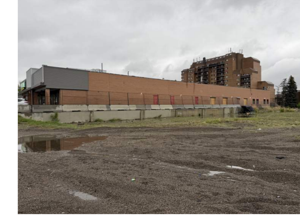
EXISTING SITE PHOTO 4 SCALE: N.T.S.
