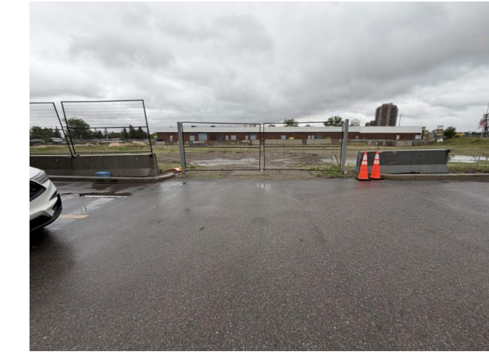
EXISTING SITE PHOTO 2 SCALE: N.T.S.
