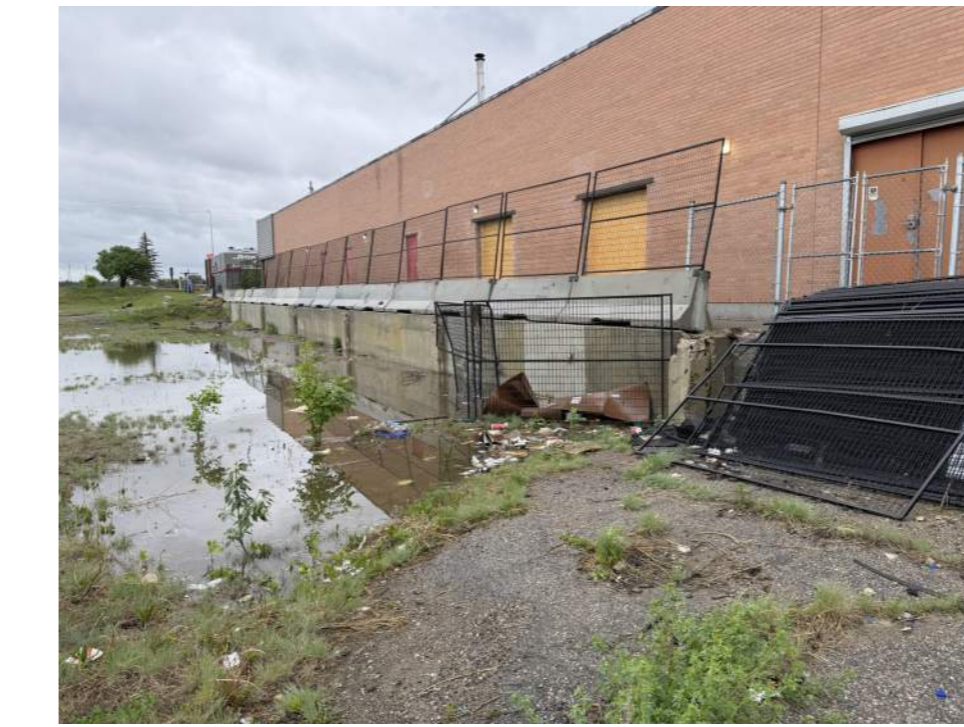
EXISTING SITE PHOTO 5 SCALE: N.T.S.
