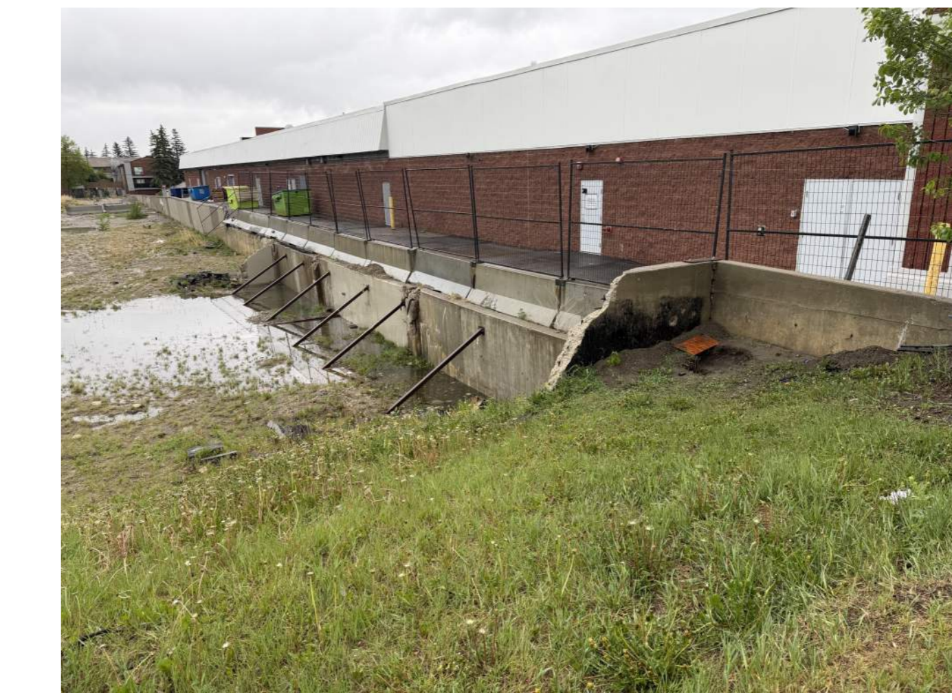
EXISTING SITE PHOTO 8 SCALE: N.T.S.
