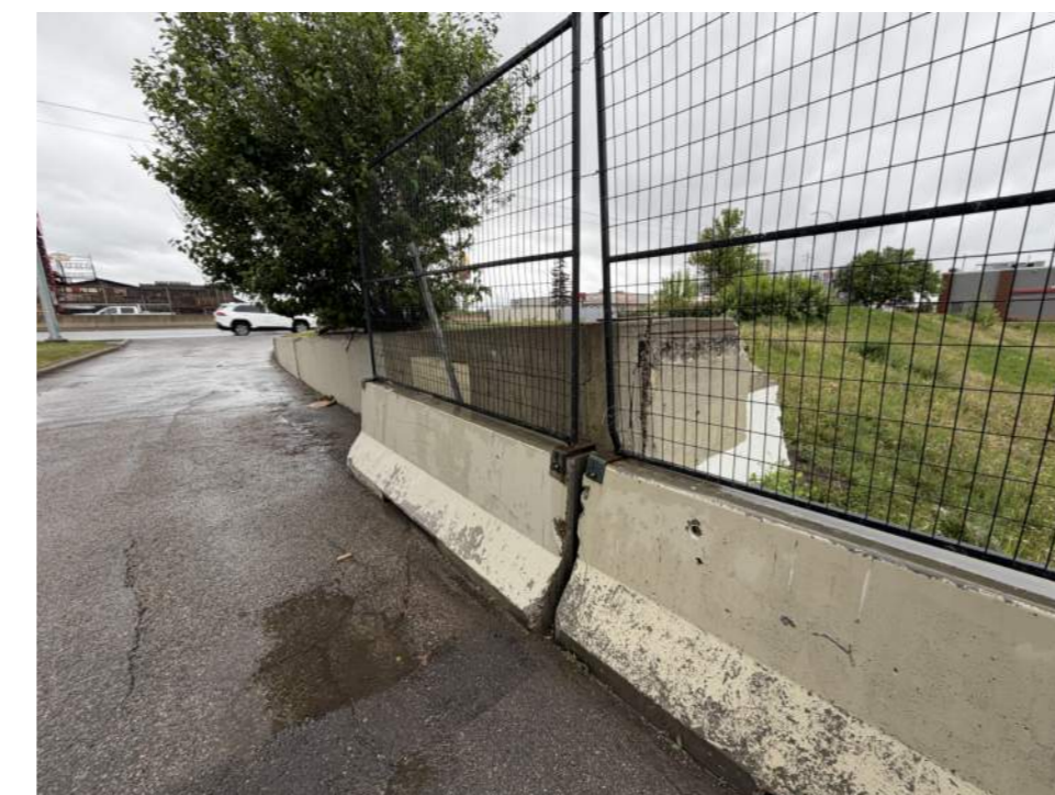
EXISTING SITE PHOTO 9 SCALE: N.T.S.
