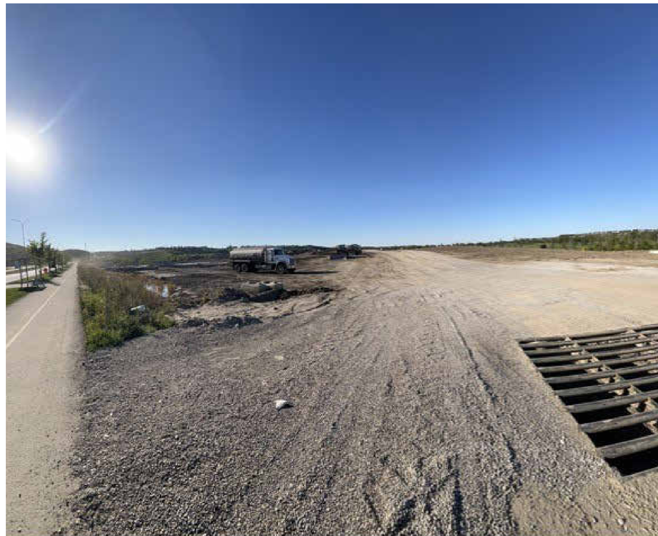
SITE PHOTO 2 - SE CORNER SCALE: 1 : 250
