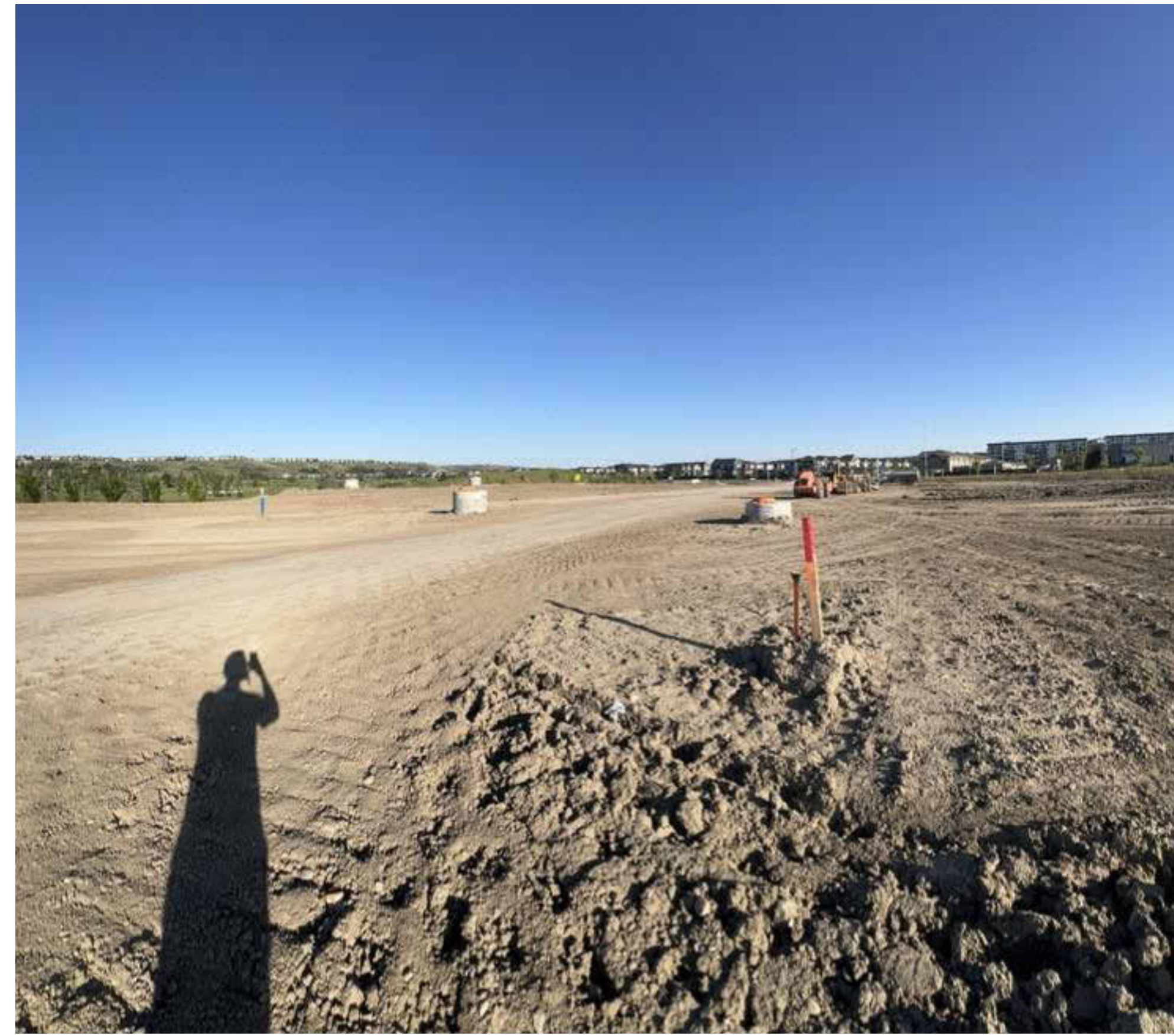
SITE PHOTO 7 - NE VIEW SCALE: 1 : 250
