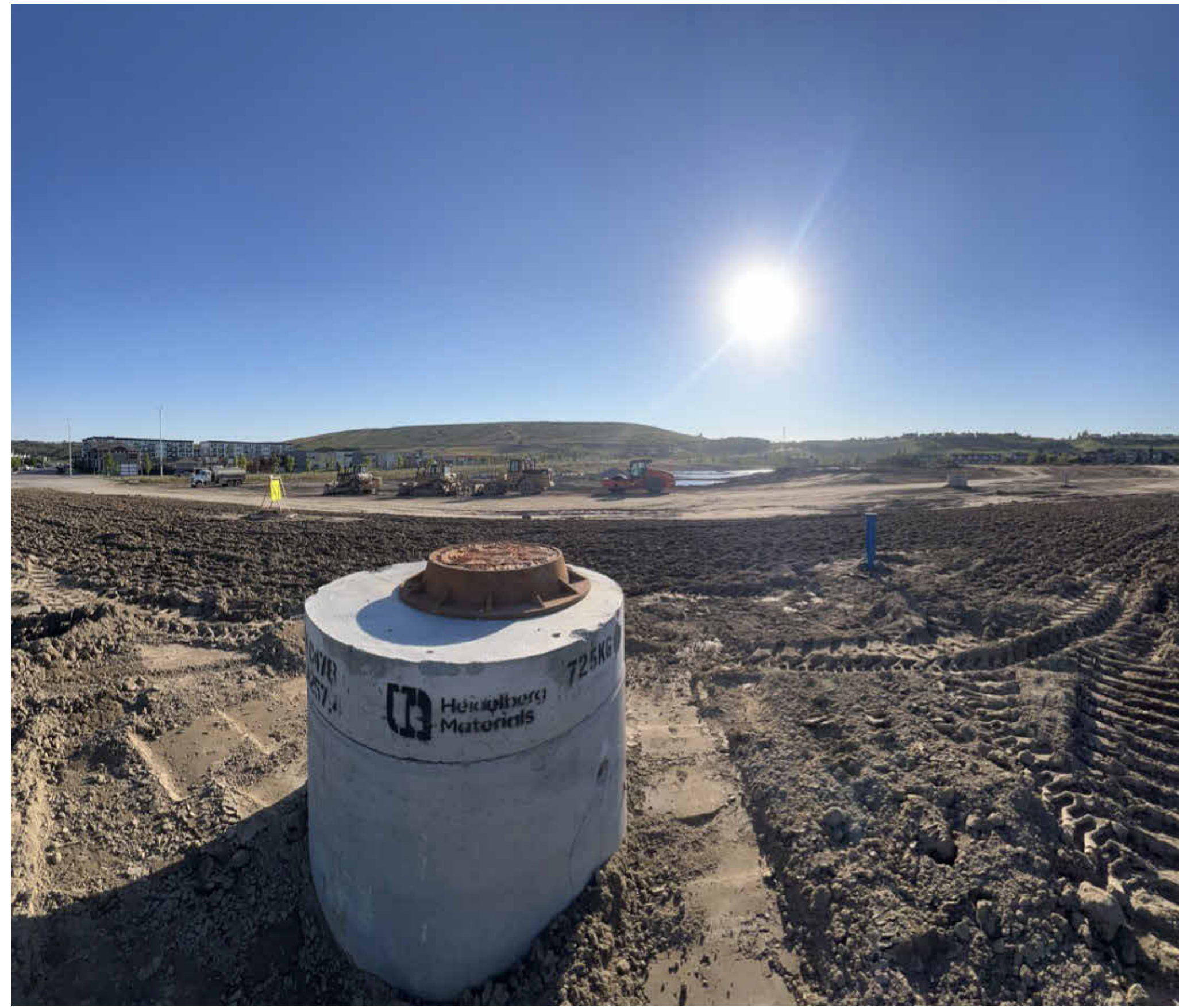
SITE PHOTO 8 - NE CORNER SCALE: 1 : 250
